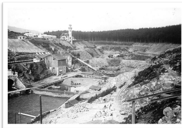
Staveniště stavby – r. 1912
